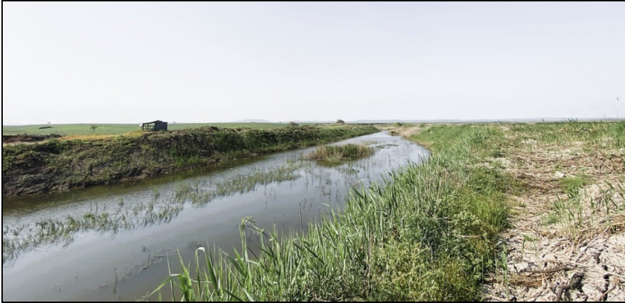
Fotoğraf 1.5: Kanal (Köprüden Kıyısından Kuzeye Bakış) (Foto: KG, 14 Nisan 2024) ( https://www.kemalgozler.com/kanal-kuzey-12-4-2024.jpg )
